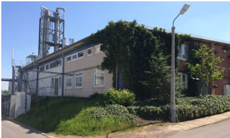
Bereich Gießereiservice: Produktionsgebäude mit Destillationskolonnen
