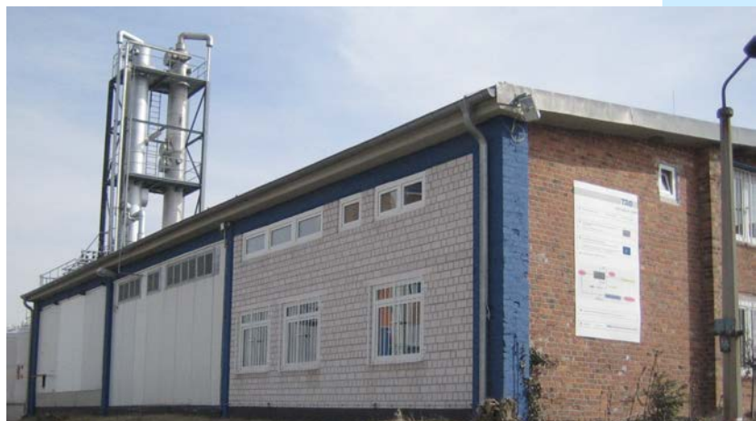
Produktionsgebäude des Bereiches Gießereiservice mit Destillationskolonnen
